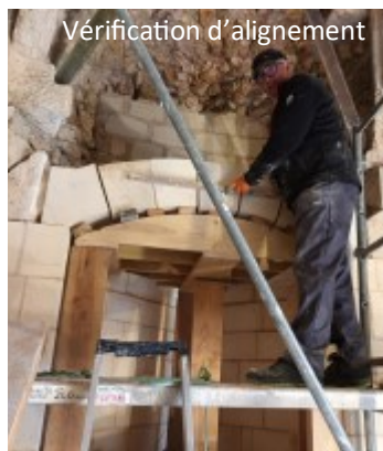
Pose des pierres de façade avant calage
