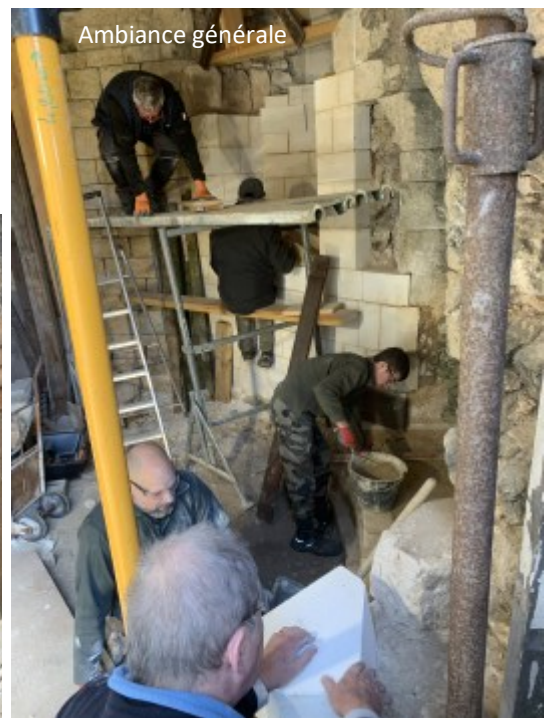
Coffre pour la pose de la voûte
