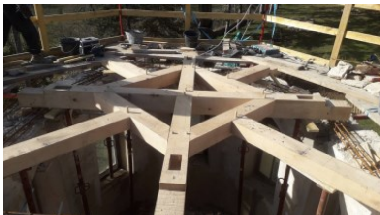
Deux exemples d'assemblage de la partie horizontale de la future charpente
