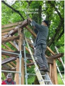
Une matinée a 10 bénévoles sur les toilettes, ca dépote: on pourrait instaurer un système de ticket. Passage de câble, découpe de blocs, pose de chevrons complémentaires, préparation de liant, pose de blocs, préparation de la porte, dégagement de gaines, logistique de toutes ces actions, le programme était copieux. Encore une douzaine de blocs à poser et on attend la volige.
