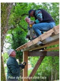
Il sera discret et même invisible mais sur la volige, a été fixé un film d'étanchéité spécial toiture pour éviter toute infiltration d'eau de pluie en cas de détérioration de tuiles.
