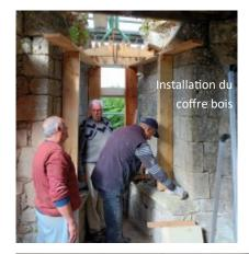
Le coffre conçu et utilisé sur une première fenêtre il y a quelques semaines au 2° étage de la tour, a été repositionné avec succès sur la seconde fenêtre au même étage. Le même jour, douze pierres préalablement taillées ont été acheminées aux étages. Il est prévu d'utiliser ce coffre l'année prochaine au 3° étage pour la reconstruction de deux fenêtres identiques. En 2 séances les douze pierres ont été mises en place et vont être scellées.
