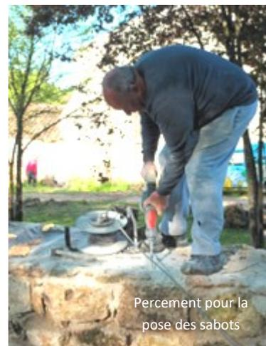
Percement pour la pose des sabots
