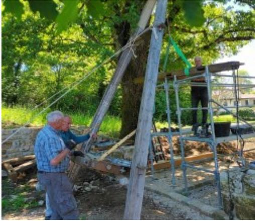
C'est ainsi que l'ensemble des bois d'un certain poids, seront acheminés en hauteur pour être mis en place sur des poteaux. Une gravure ci-dessous est similaire à notre équipement. Ce premier essai donne l'idée de construire une cage à écureuil par la suite pour les travaux sur la tour.
