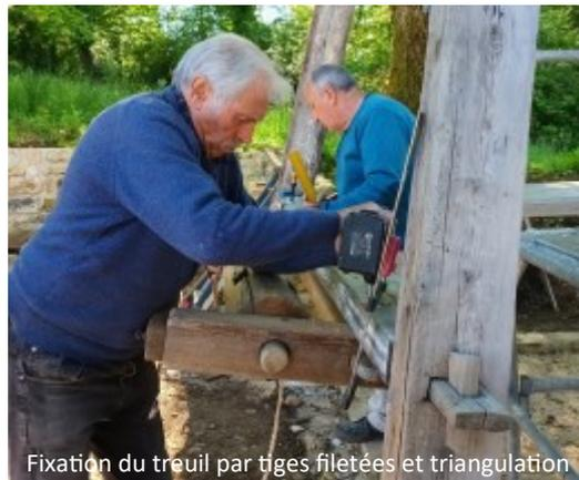
Fixation du treuil par tiges filetées et triangulation
