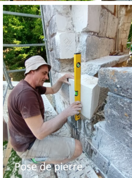
Restauration ébrasement de fenêtre
