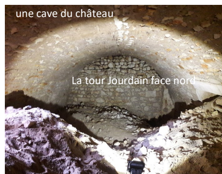
L'entrée du souterrain
