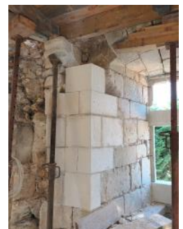
Dépose de pierres d'un coussiège
