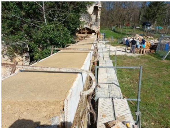
Scellement d'une pierre de chaînage
