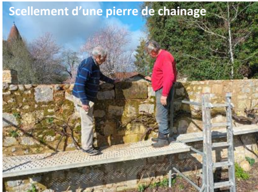
Réalisation de l'arase à la chaux
