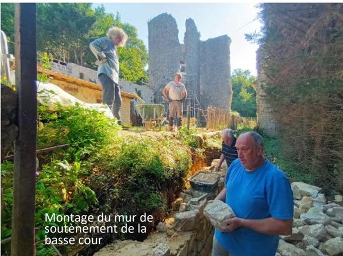
Montage du mur de soutènement de la basse cour
