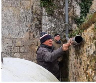
La dalle de béton étant sèche, la citerne y a été glissée et nos techniciens émérites ont procédé au raccordement sur le réseau d'eau de pluie de la toiture de l'église. La citerne va donc pouvoir se remplir à nouveau pour l'arrosage des bacs du jardin médiéval. L'eau et l'électricité sont dans la maison du four à pain.
