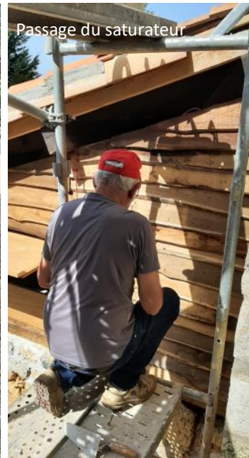
Réalisation de joints
