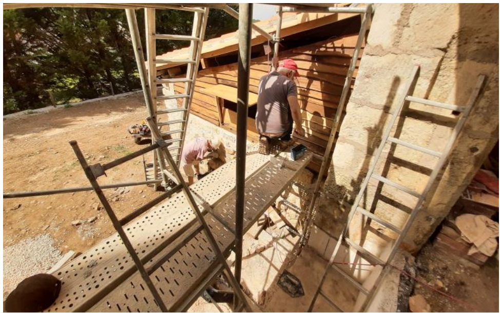
Réalisation de joints
