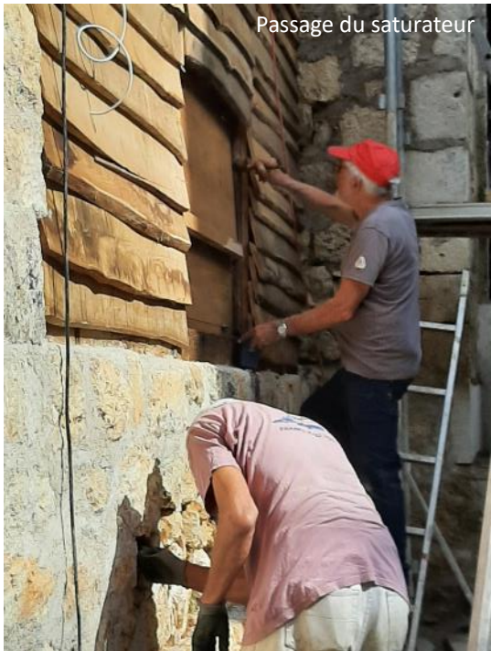
Réalisation de joints
