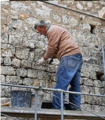
Le mur de soutènement du porche a aussi fait l'objet d'un enduit par Marcel après avoir remplacé deux pierres de taille. Guy aidé de Jan a procédé à la pose d'une partie du bardage du pignon Est de la maison du four à pain.
