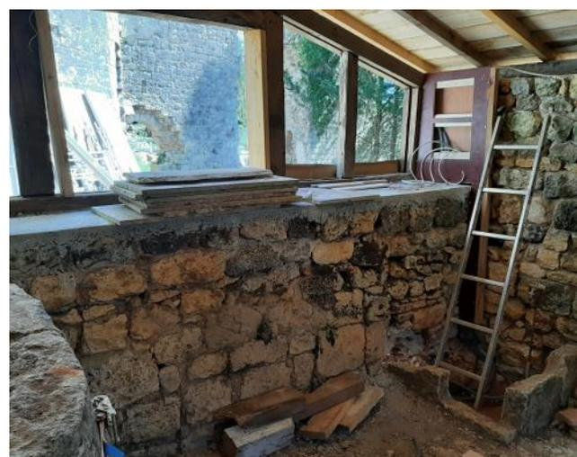
Ce sont à nouveau des travaux de sécurisation du site qui étaient au menu ce samedi 2 avril très frisquet. Pour sécuriser l'accès à la basse-cour et le talus, un muret en moellons a été monté à la chaux de saint Astier, sur 1,2m de hauteur à l'entrée et ensuite sur simplement deux rangées
