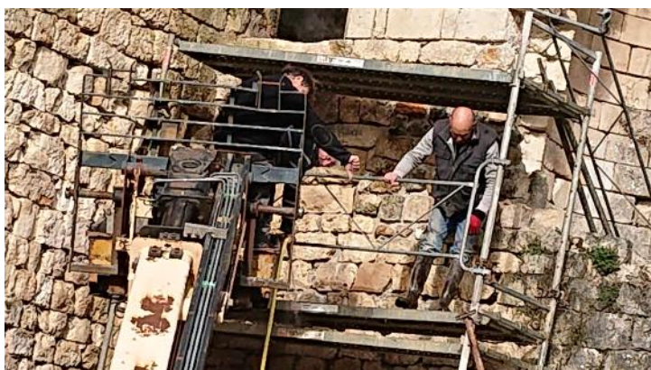
Début étalement du béton batard allégé
