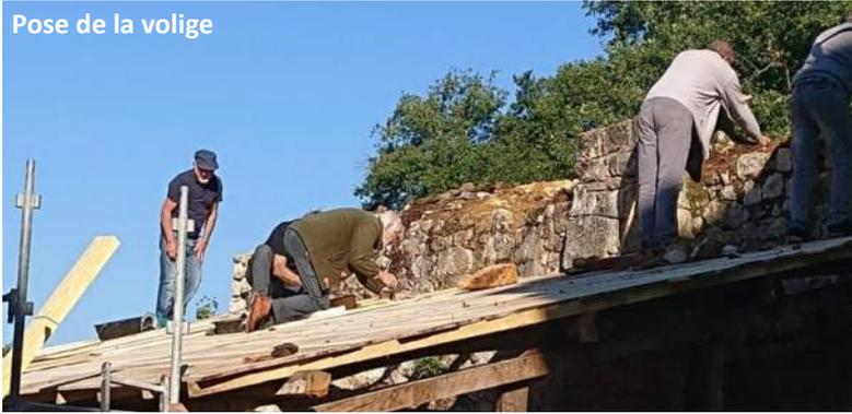
Suite de la pose de la volige de la maison du four à pain et préparation de la tête de mur de courtine pour permettre au chantier d'insertion de l'araser proprement.
