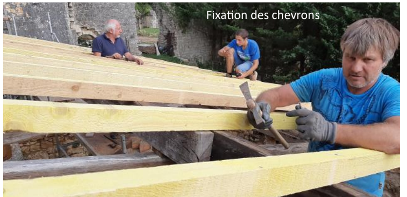
Assemblage Entrait, arbalétrier, pannes et échantignole à l'ancienne
