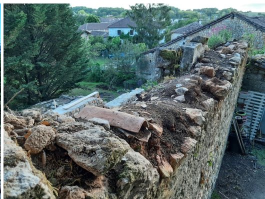
Tête de mur au-dessus de la maison du four à pain
