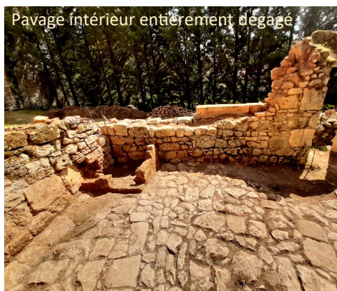
Réserve d'eau dégagée et ceinturée
