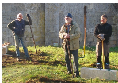
Décapage du terrain
